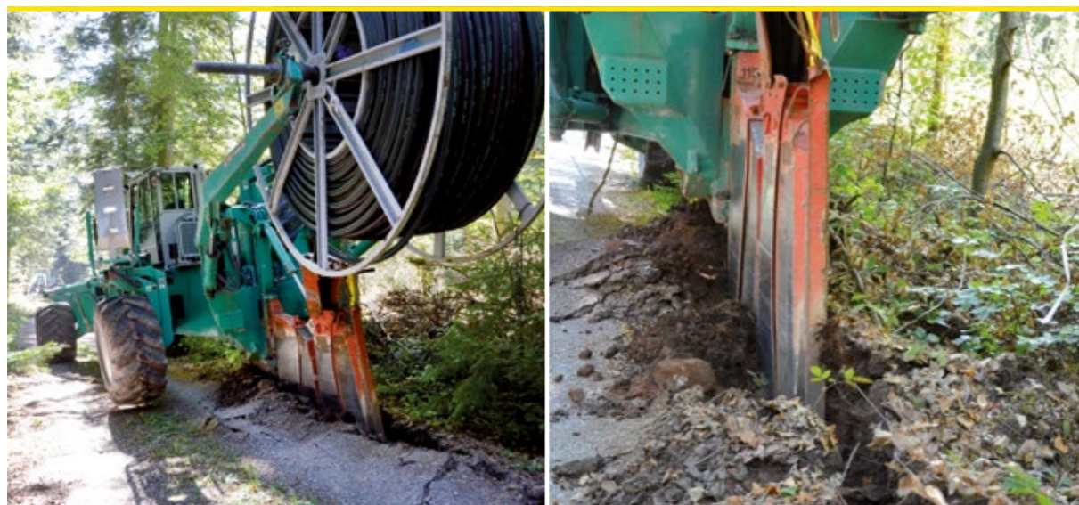
Kabelpflug im Einsatz
