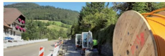
Verlegung von Rohrverbänden im Straßenkörper
