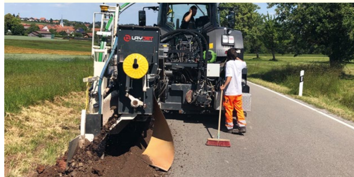
LAYJET-Verfahren im Einsatz
