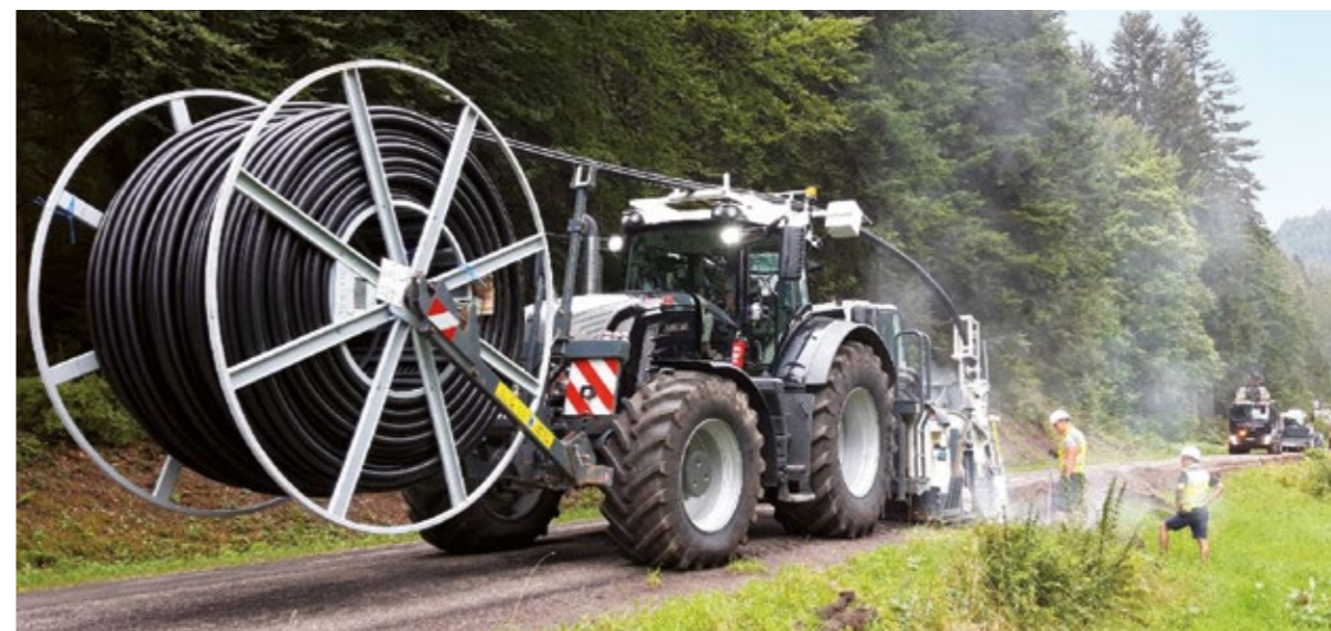
Tiefbauarbeiten mit Kabelflug im Landkreis Calw
