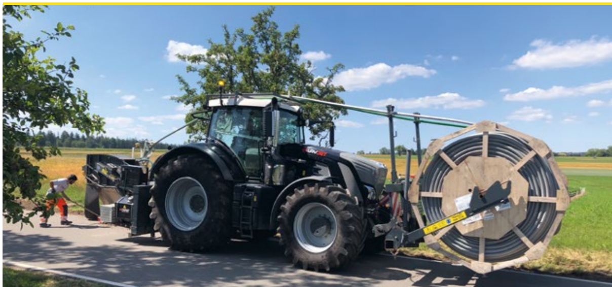
Verlegung von Rohrverbänden entlang der Straße
