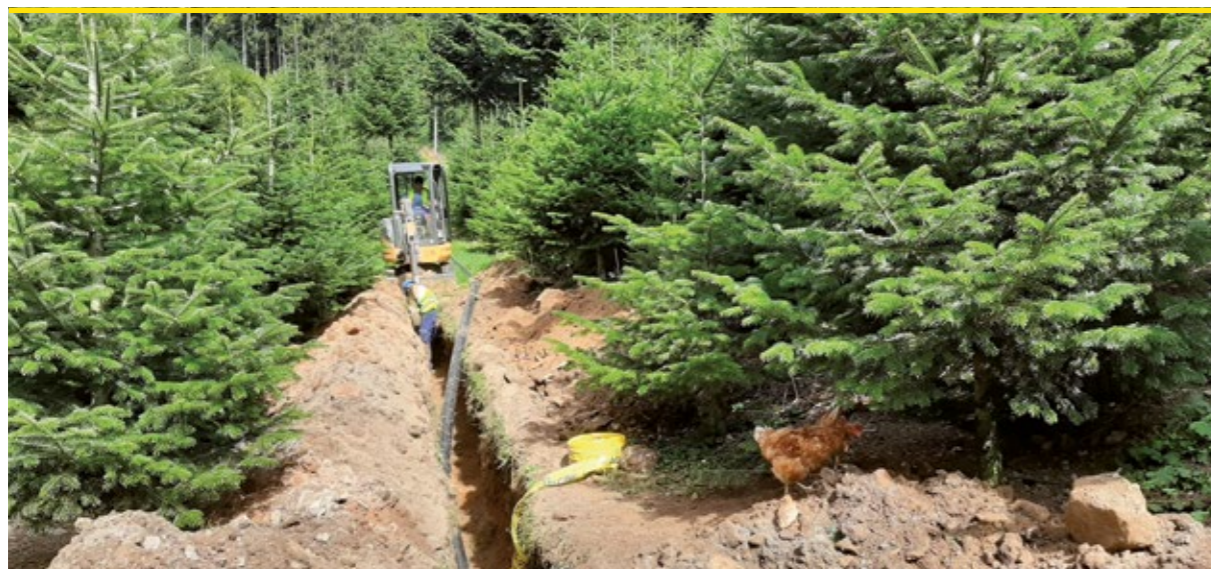
Verlegung von gigabitfähiger Glasfaserinfrastruktur durch unwegsames Gelände
